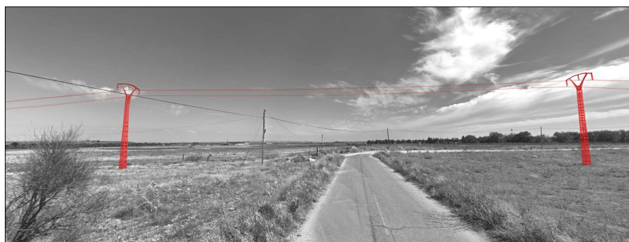
Línea eléctrica aérea de media tensión de 20 kV
